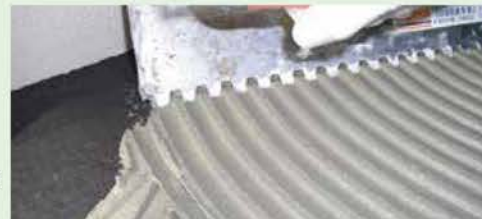
На UNOLASTIC можно укладывать плитку или шифер, фиксируя их непосредственно на растворных бордюрах.
