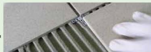
На UNOLASTIC можно укладывать плитку с помощью клея C2, S1/S2
