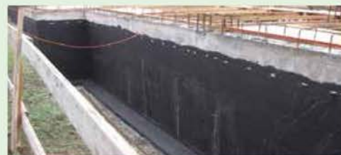
Защита гидроизоляции с PROTEFONTEX или PSE панелей
